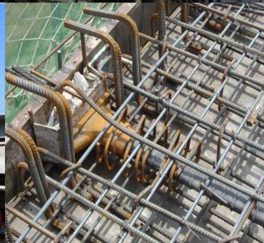
混凝土结构的预应力——结构服役前，预先施加压应力，以优化结构受力状态。
